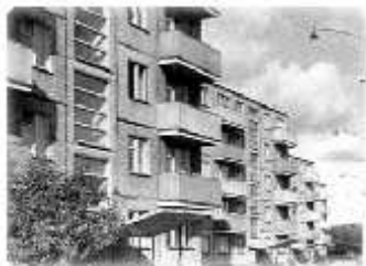
рис.1. Консольные балконы. Рядовая застройка жилого района, г.Талин, Эстония.
