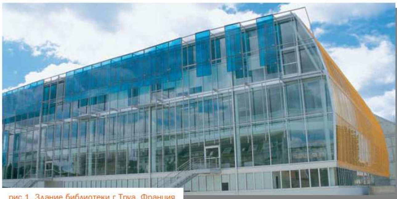
рис.1. Здание библиотеки г.Труа, Франция
